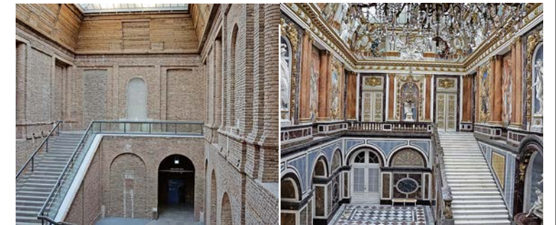
Im Gegensatz zum südlichen Treppenhaus ist das nördliche noch im Rohbau verblieben. König Ludwig II. durfte damals kein Geld mehr ausgeben.
